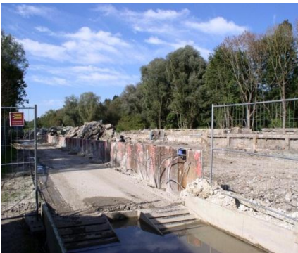
LKW-Waschanlage am Südausgang der Baustelle
